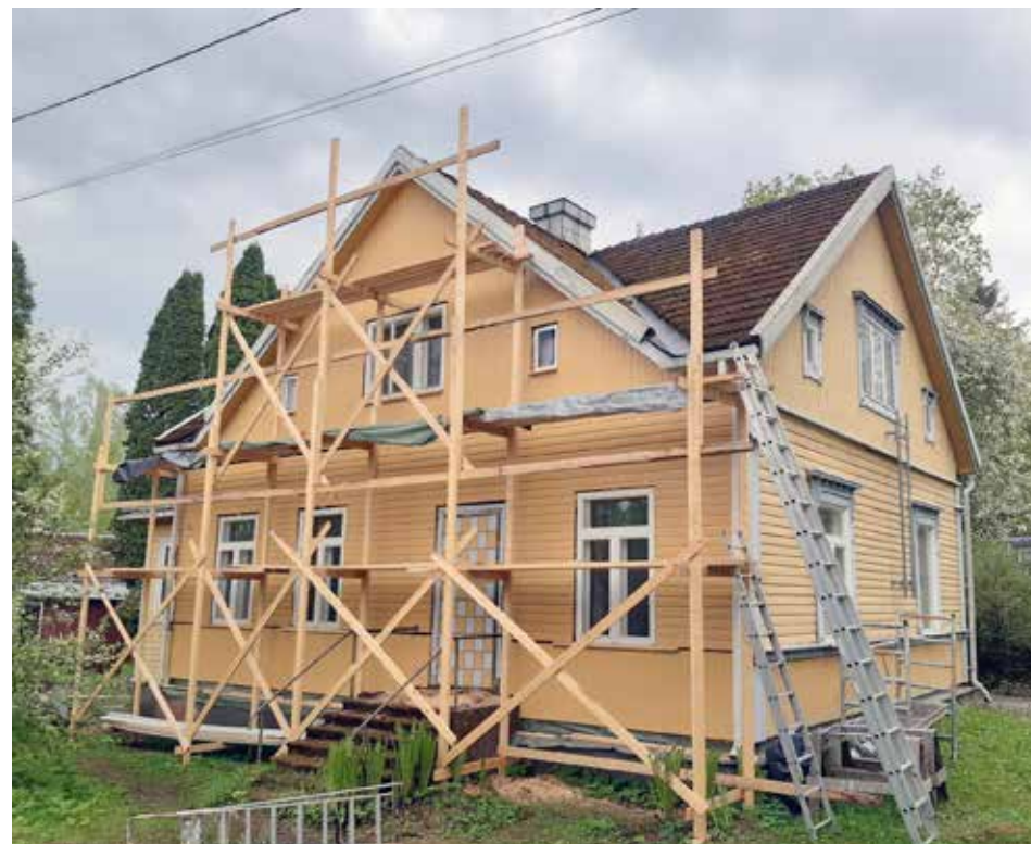
Korjausrakentamiskohde. Kuva: Anssi Malinen.
